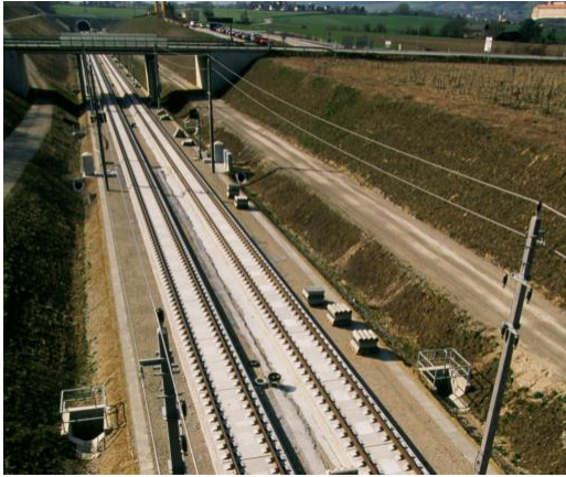
67 % freier Strecke 60,5 (121 km)
