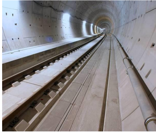
17 % im Tunnel 16,5 (31 km)
