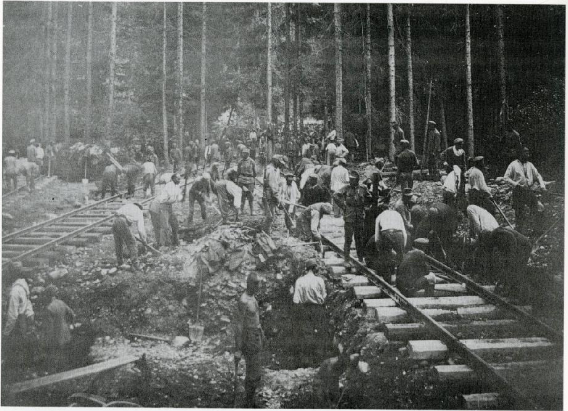
Verlegungsarbeiten der Artilleriegleise für die Küstenhaubitze K.H.L./15, 3. Batterie
