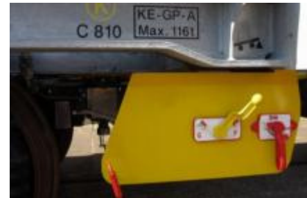
Eine Bremsanlage für den Doppelwagen
