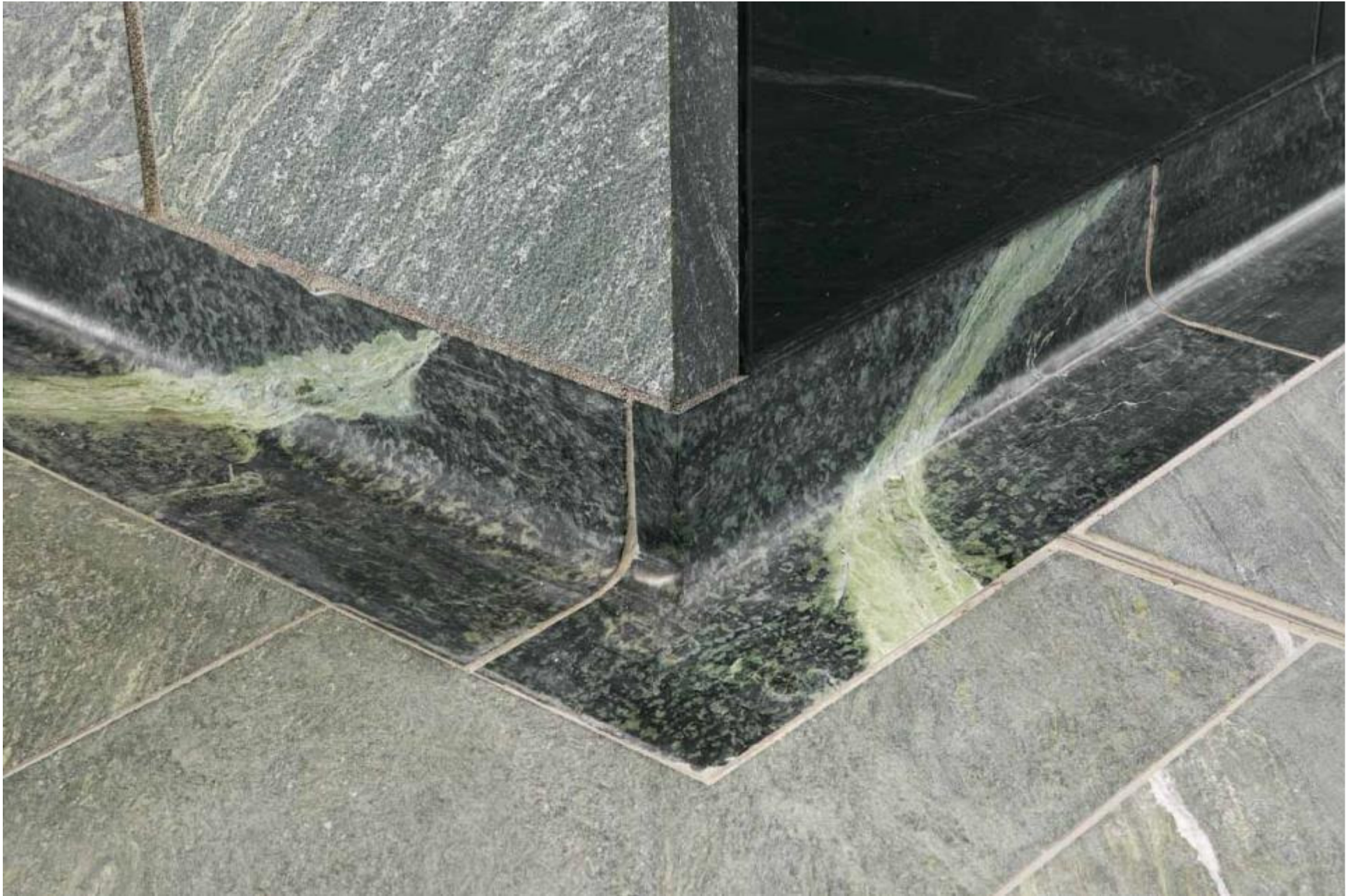
Bodenbelag / Wandanschlussdetail
