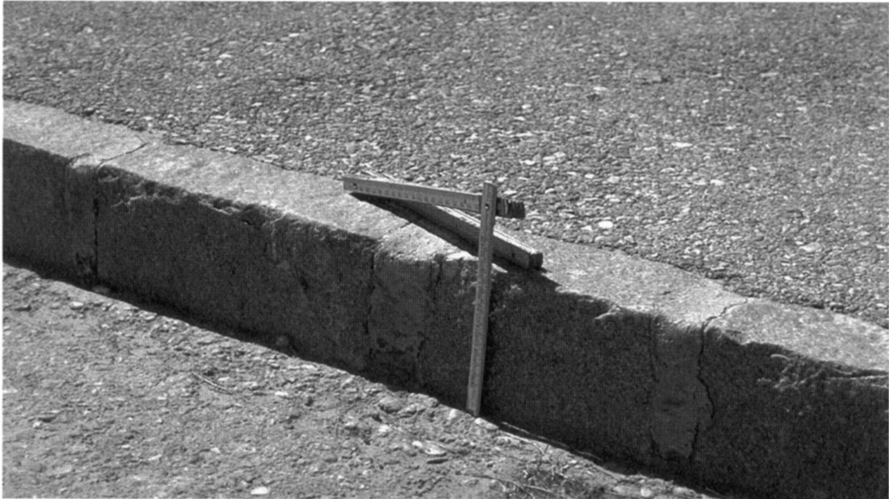
Foto 31: Bordsteine bilden eine dirigistische Maßnahme gegen den Fußgerverkehr und sind in einem me
