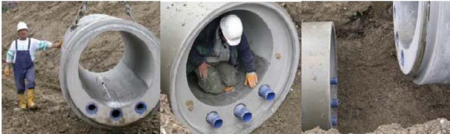
Rinnenwärmetauscher als vorgefertigte Elemente
