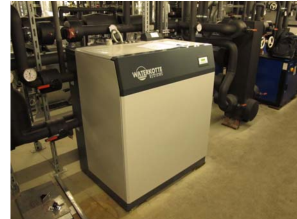
Wärmepumpe U2 Taborstraße: 42,4 kW Wärmeleistung, 7,8 kW Leistungsaufnahme
