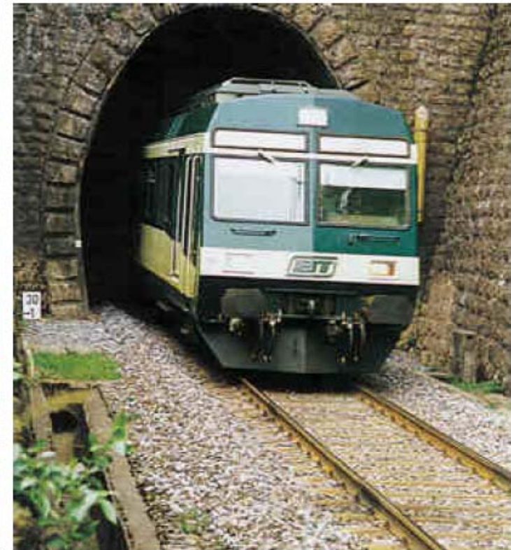
Rickentunnel (Schweiz) - Nutzung des Drainagewassers zur Beheizung von Gebäuden
