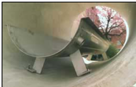
Rinnenwärmetauscher mit glatter Oberfläche für Kanäle mit Kreisprofil
