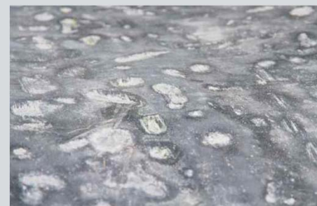
Ausgebaut mit Abdrücke Schotterkörner
