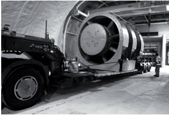
Abbildung 1: Für frische Luft im Gotthard-Basistunnel sorgen Großventilatoren der TLT-Turbo GmbH, die eigens für diesen Einsatz entwickelt wurden. Sie werden im normalen Betrieb ebenso benötigt wie bei Wartungs-, Service- und Reparaturarbeiten im Tunnel, aber auch für die Rauchabsaugung im Brandfall und eine separate Belüftung der Fluchtwege. Quelle: AlpTransit Gotthard AG
