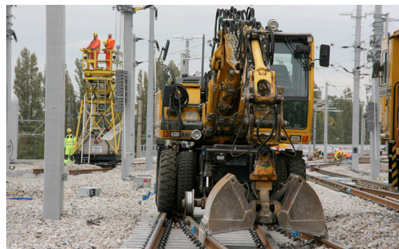
Abb. 3: Wo jetzt noch gebaut wird, fahren Ende 2012 die ersten Züge
