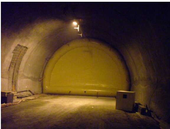
Abb. 3: Oben: Tunnel Plug während der Montage. Unten: Tunnel Plug in montiertem Zustand
