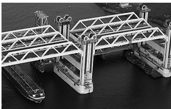
Abb. 4: Neue Botlek - Hubbrücke, eine Meisterleistung österreich. Ingenieure
