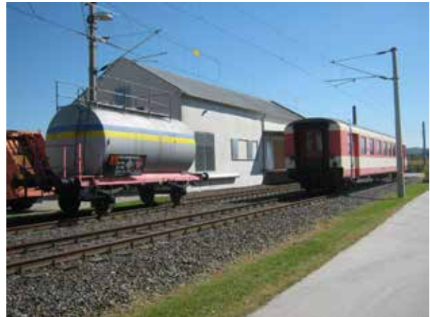
Eigene Gleisanlage am FWS-Gelände für Übungszwecke bei Bahnunfällen.
