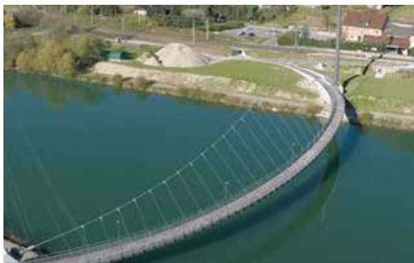
Geh- und Radwegbrücke, Puch-Töplitsch
