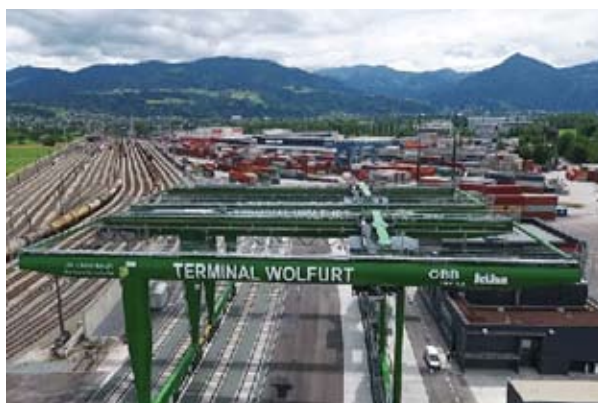
Abb.: ÖBB-Terminal Wolfurt
