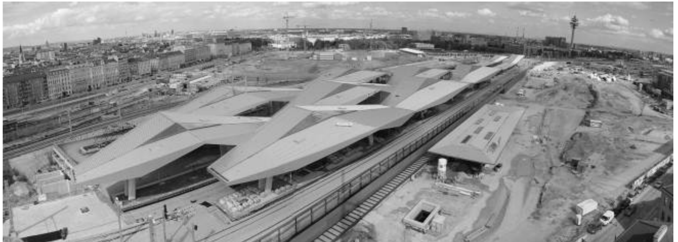
Abbildung 6: Das Rautendach und der südliche Vorplatz von der Aussichtsplattform des "bahnorama" gesehen. Der Bahnhof als Zentrum des "Quartier Belvedere". Links die Hausfronten des Wiedner Gürtels. Die Kräne im Hintergrund markieren die Lage des ehemaligen Südbahnhofs, jetzt entsteht an dieser Stelle der Campus der "Erste Bank". (Sigi Herzog/ÖBB, 21.4.2012)
