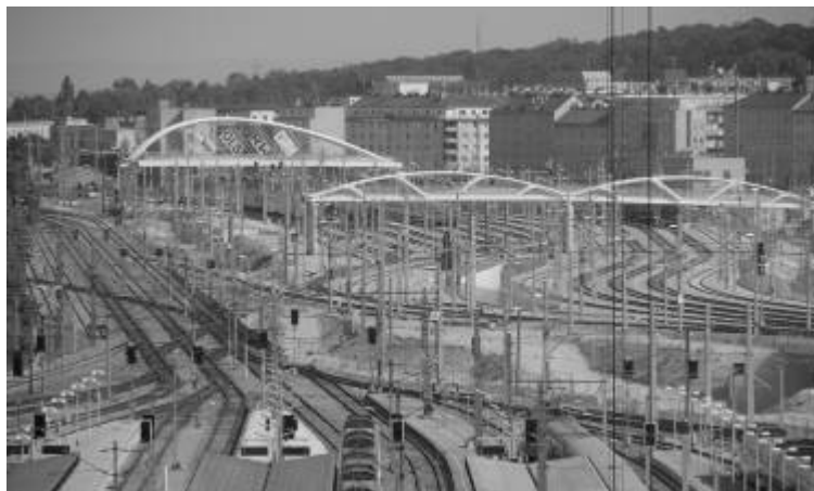
Abb.3: Die Ostbahn und der anschließende Frachtenbahnhof trennt den dritten Bezirk (links) vom zehnten Bezirk. Zukünftig verbinden Brücken diese beiden Bezirke. Die Brücke im Vordergrund der "Arsenalsteg" für Fußgänger und Radfahrer. Im Hintergrund die "Südbahnhofbrücke" für Autos. Im Vordergrund der verkürzte Ostbahnhof. (Sigi Herzog/ÖBB, 2.7.2012)
