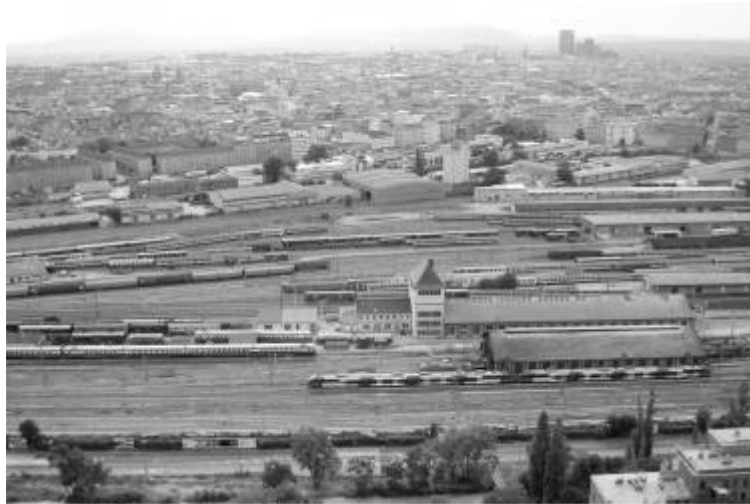
Abbildung 2: Blick vom Richtfunkturm Arsenal auf den mittleren Teil des Frachtenbahnhofes, das zukünftige Herzstück des Parks. Dieser wird über den Arsenalsteg mit dem Arsenal verbunden. Im Vordergrund die Ostbahn (Sigi Herzog/ÖBB, 4.9.2008).
