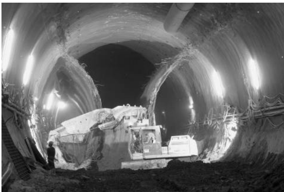
Abb. 4. Ulmenstollenvortrieb Lainzer Tunnel
