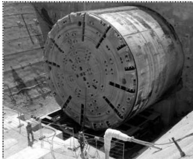
Abb. 3. Tunnelvortriebsmaschine Tunnelkette Perschling
