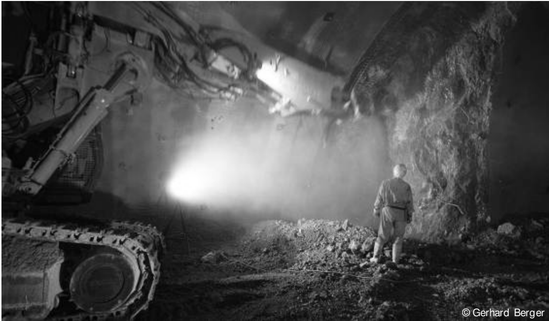
Bild 3: Bergmännischer Tunnelbau, Tunnel Brixlegg
