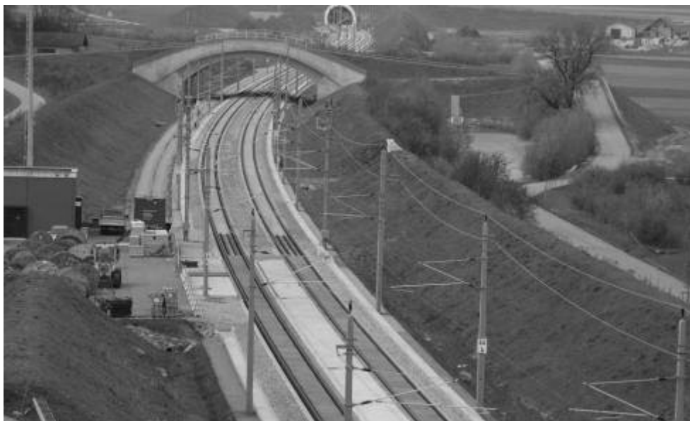
Abb. 5. Oberbauarbeiten an der Freistrecke
